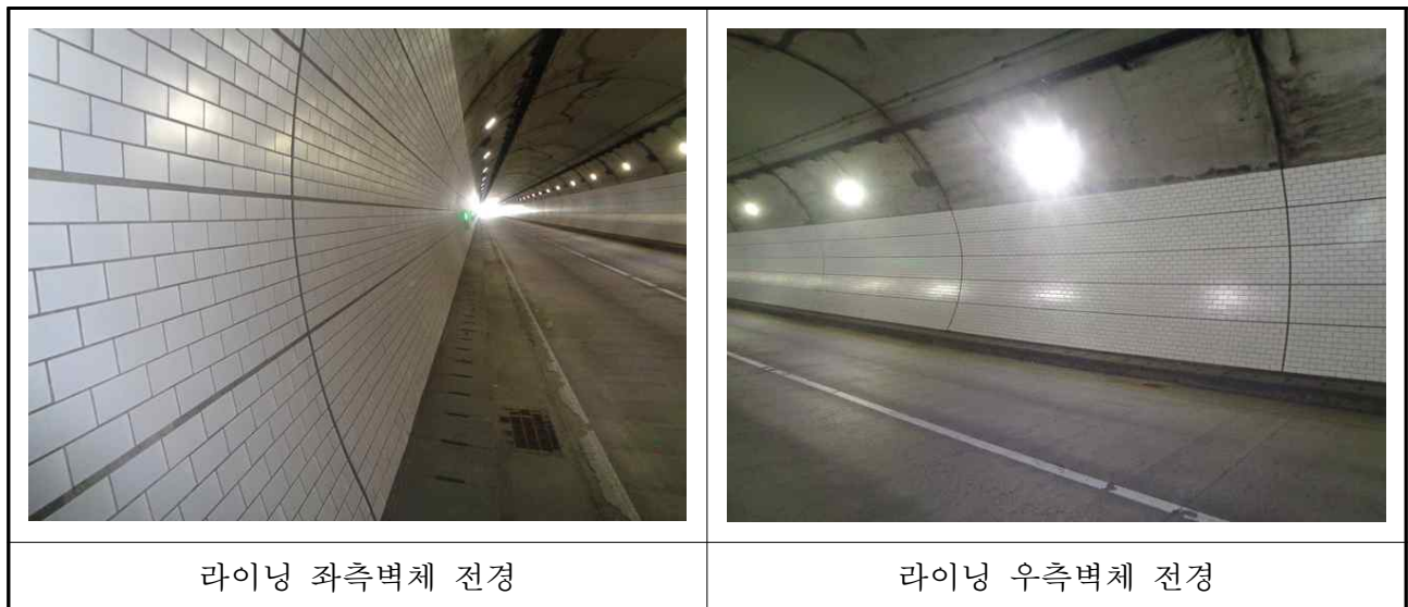
【사진 3.5】 터널 라이닝 측벽부 전경
