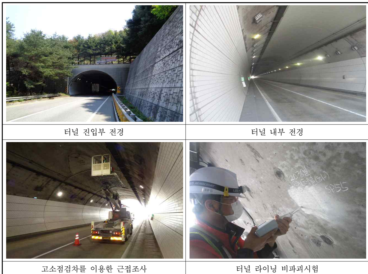
【사진 3.2】 근접조사를 위한 장비 사용 전경
