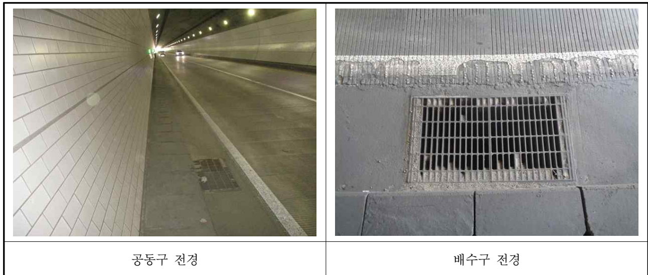
【사진 3.11】 공동구 및 측구(배수로) 전경
