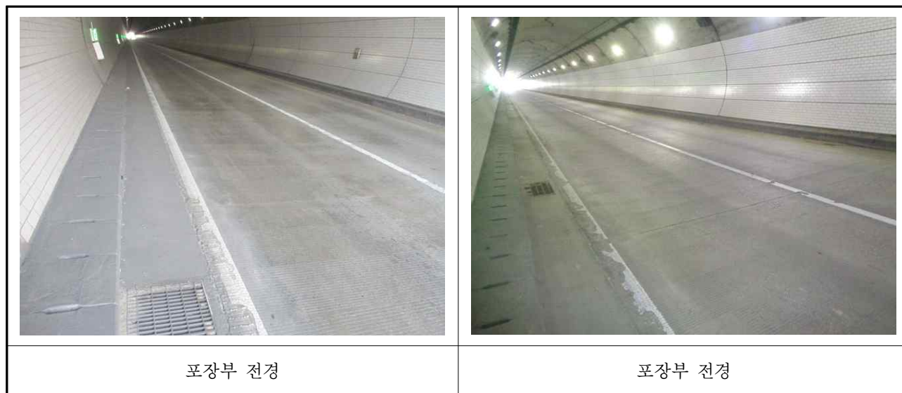
【사진 3.13】 터널 포장부 전경
